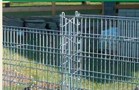
Höhenunterschiede des Untergrundes lassen sich durch eine variable Gitterbefestigung am Pfosten oder auch durch spezielle Gitterelemente ausgleichen.
